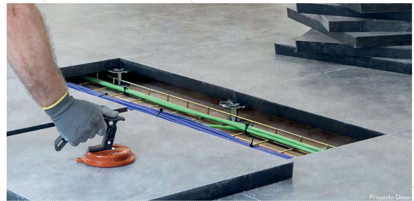
El suelo técnico está especialmente indicado para centros de proceso de datos en los que la cantidad de instalaciones es considerable. Las rejillas metálicas permiten conducir los cableados de forma ordenada.
